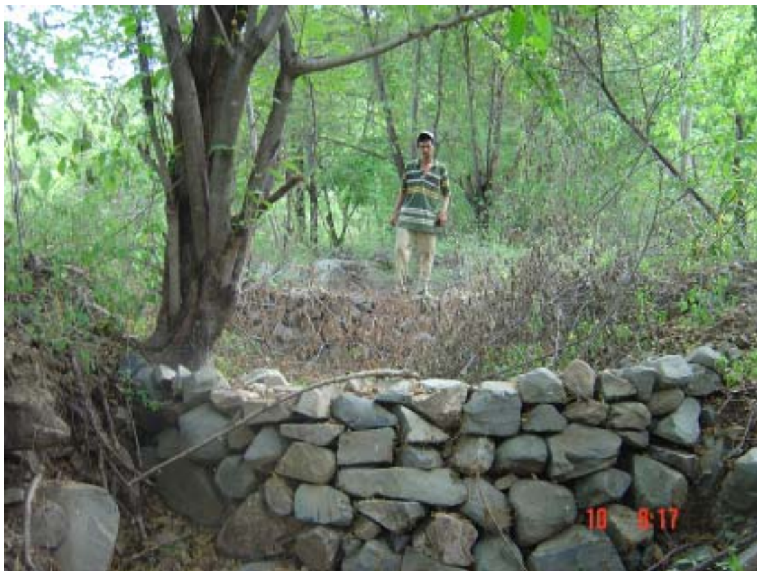
Diques construidos por el productor Héctor Guevara de Cinco Pinos, Chinandega
